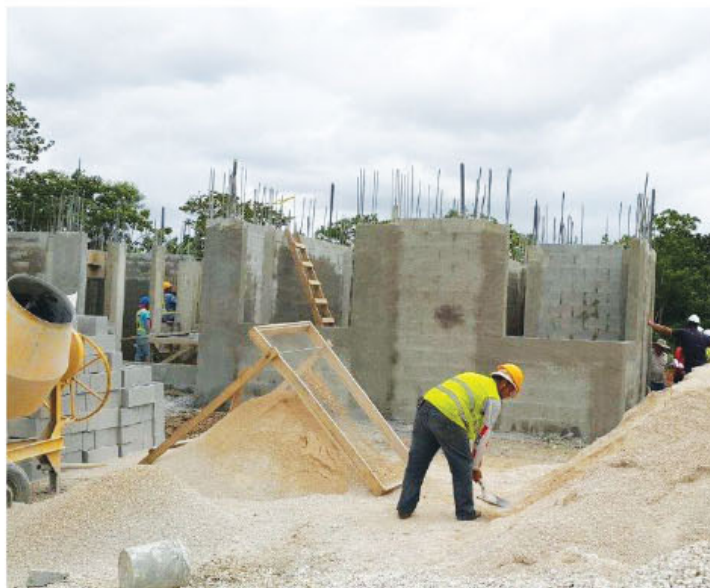
Avanzan obras de la torre del Hospital de la Anexión.
