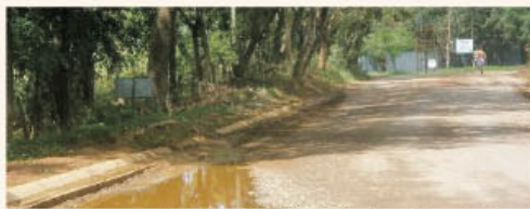
En los próximos meses la Municipalidad de Santa Cruz invertirá unos $94 millones en el acondicionamiento de una parte de los 2,8 kilómetros de la ruta de lastre que comunica el centro de Playa Tamarindo con Playa Langosta.
