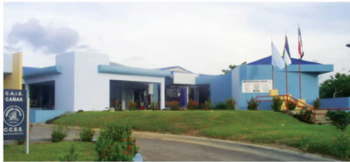
Vista del edificio del CAIS en Cañas.
