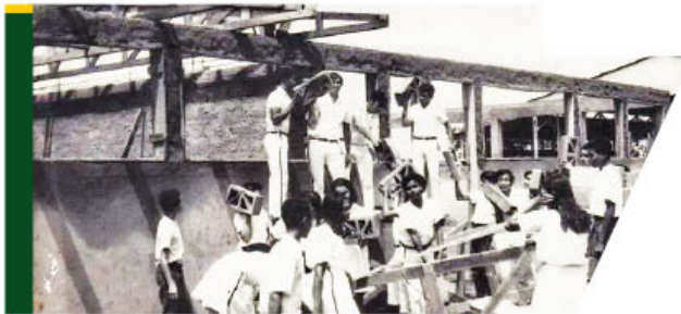
En el actual terreno donde se construyó la infraestructura del Instituto de Guanacaste, se observa el servicio social que practicaban los estudiantes de la época al formar parte del equipo colaborador en la construcción del colegio. Crédito de fotografía Instituto de Guanacaste.
