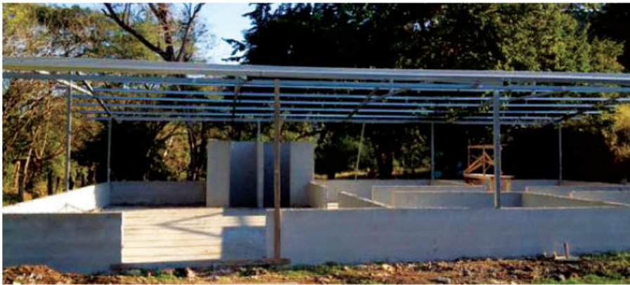
Construcción del Centro de Reciclaje avanza.
