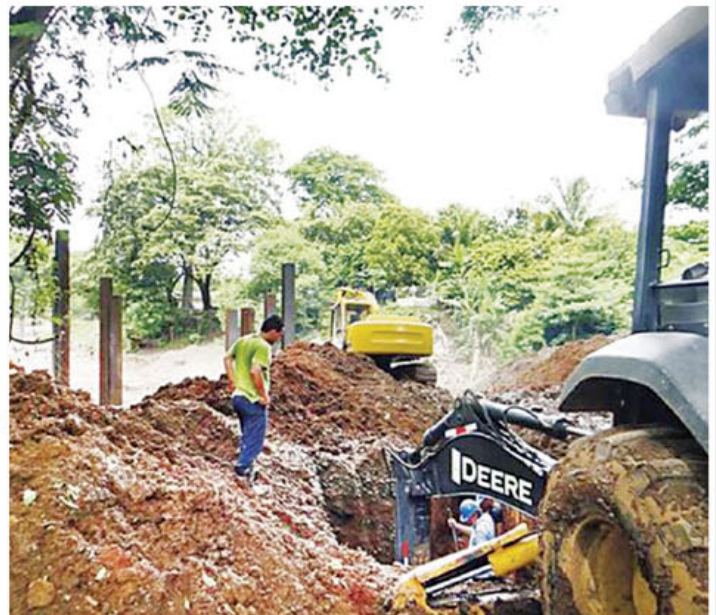
Construcción de puente sobre el río Brasil.
