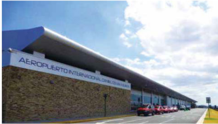
Se estima que la nueva ruta hacia el Aeropuerto Daniel Oduber será de seis kilómetros.
